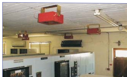
Protección de sala de servers
