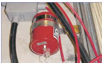
Protección piso elevado
