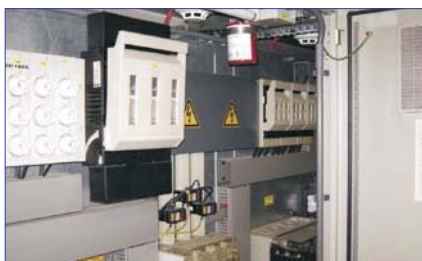
Protección de tableros electricos
